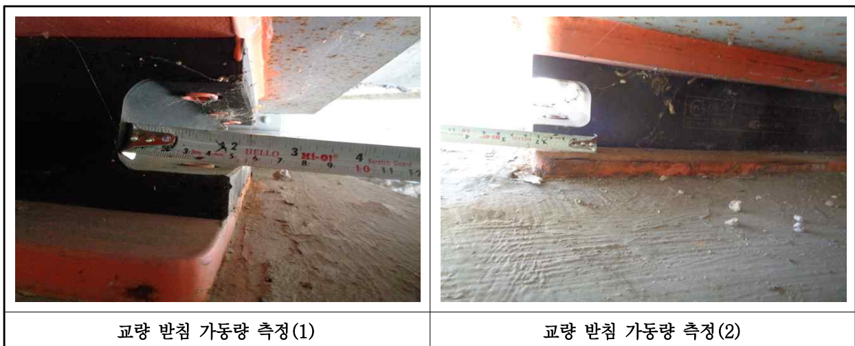
【사진 4.3.15】교량받침 이동량 측정
