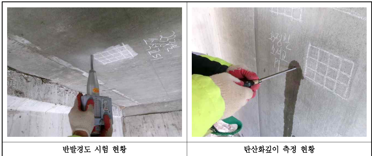
【사진 4.4.1】 콘크리트 내구성조사 현황
