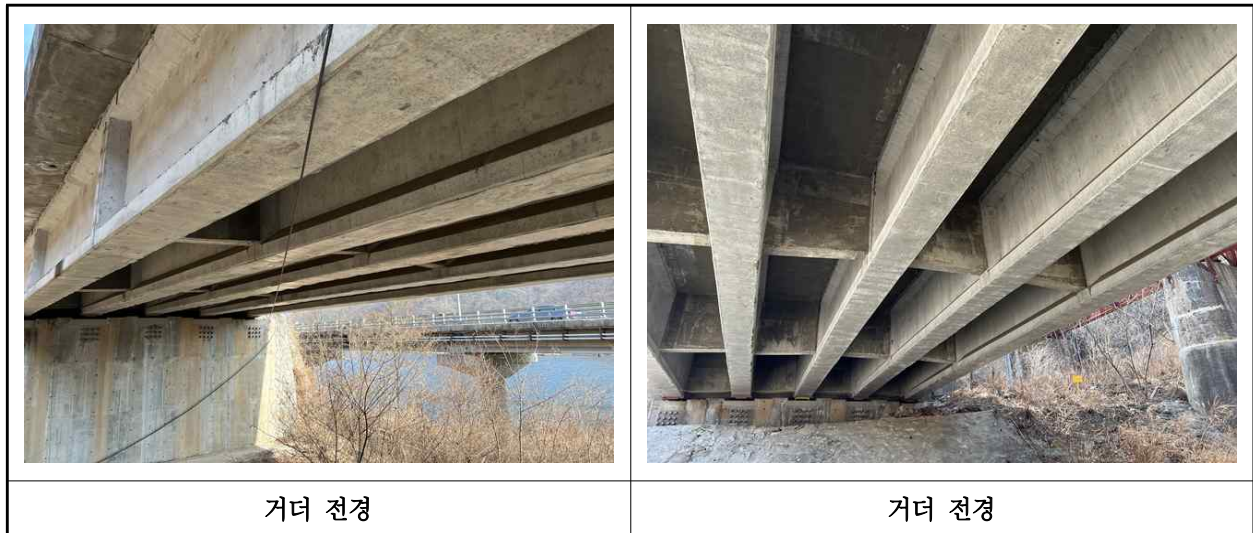
【사진 4.3.4】 거더 전경
