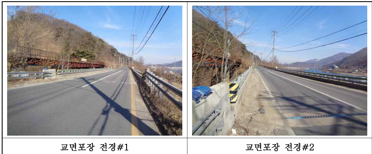
【사진 4.3.19】 교면포장 전경
