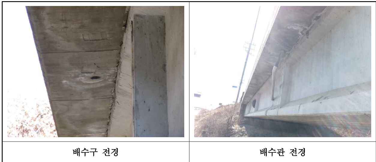
【사진 4.3.21】 배수시설 전경
