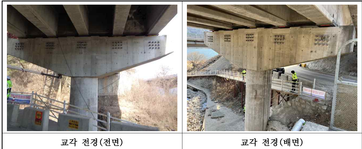
【사진 4.3.10】 교각 전경
