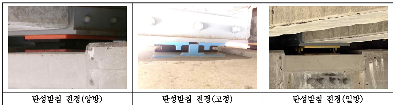
【사진 4.3.12】 교량받침 전경
