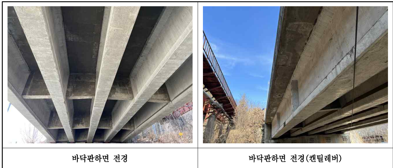
【사진 4.3.2】 바닥판하면 전경
